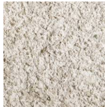
FIGURE 14 Revêtement extérieur en crépi acrylique
