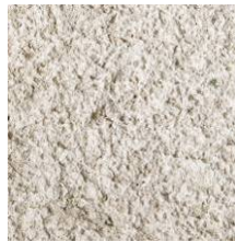
FIGURE 20 Revêtement extérieur en crépi acrylique
